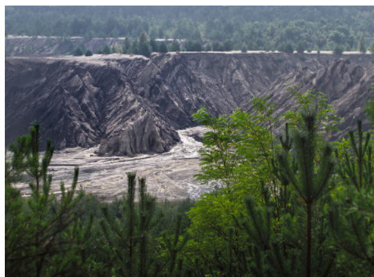
Aussichtspunkt am Restloch Westmarkscheide: unzugänglich wegen Rutschungsgefahr 2024
